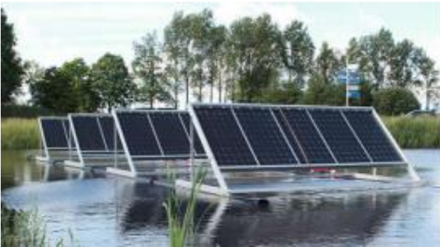
Görsel: Floatovoltaic ve Sunfloater Yüzer GES
