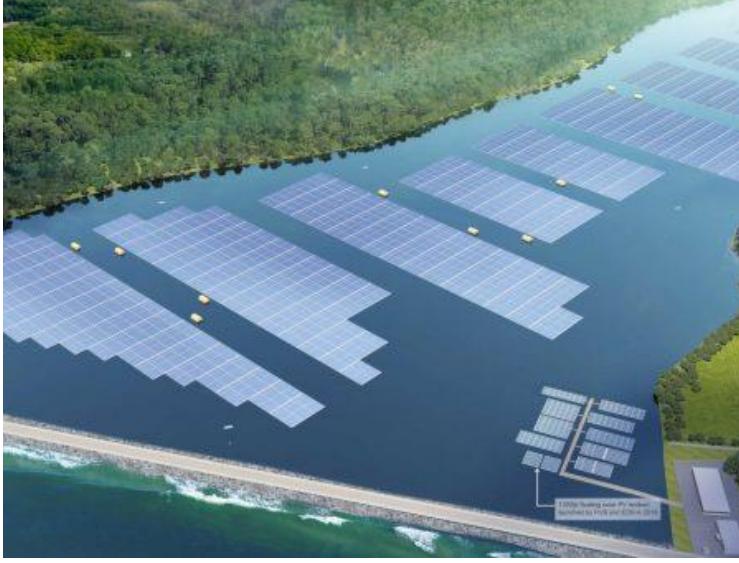
Görsel: Sembcorp's Tuas Solar Enerji Projesi
